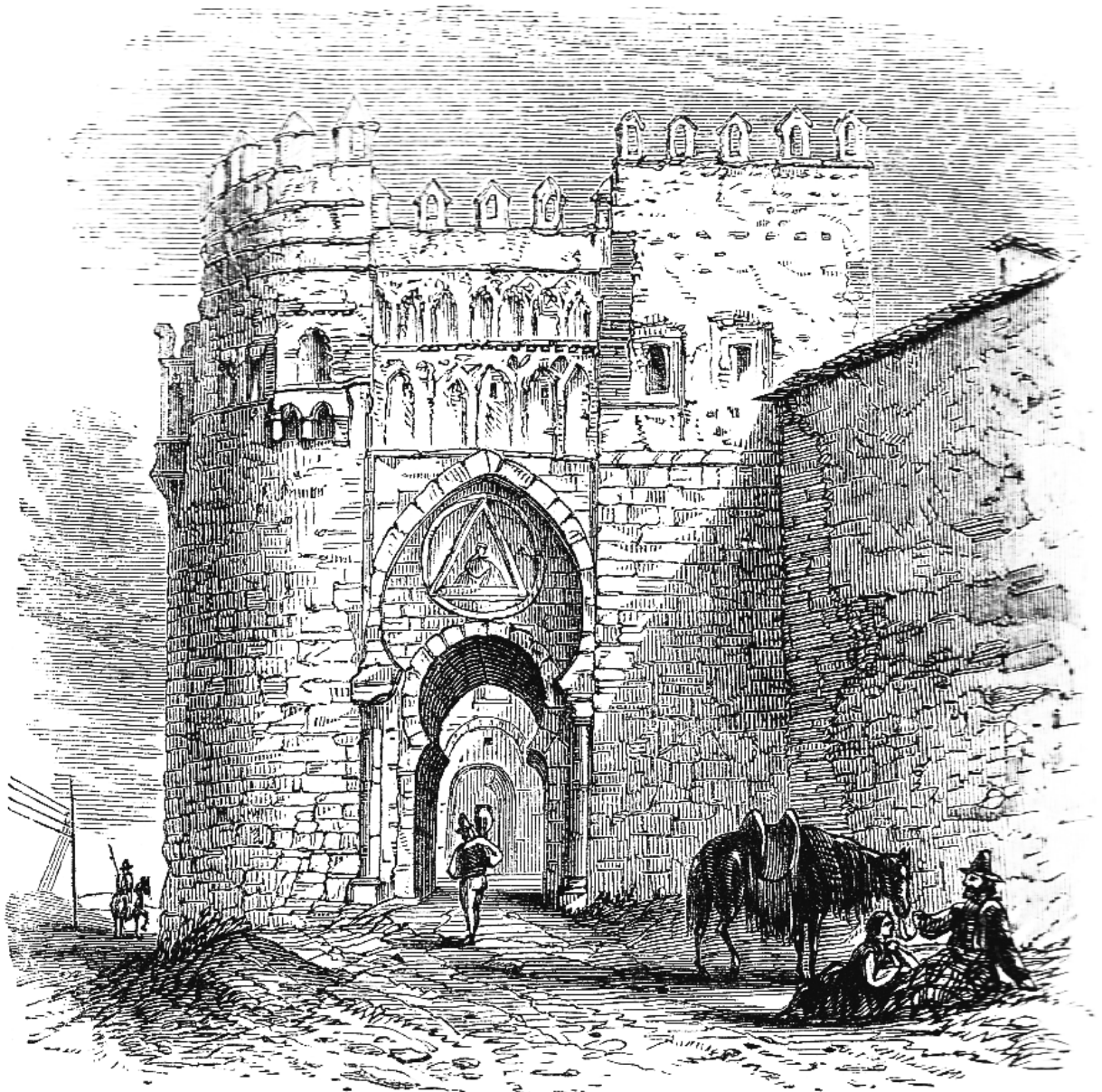
THE PUERTA DEL SOL.
