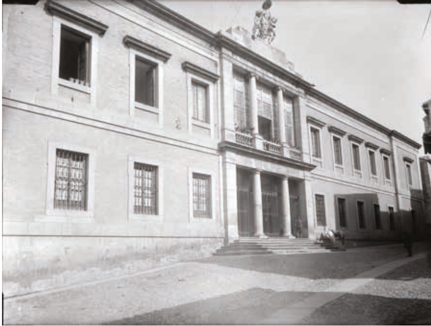
Fachada principal del hospital del Nuncio.
