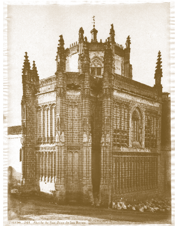
Ábside de San Juan de los Reyes. Hacia 1869 (AMT / Signatura: ALBA-PA21052). En la parte de abajo, a la izquierda, se observa el laboratorio portátil de otro fotógrafo, al estilo de Laurent, pero este es blanco y con patas cruzadas (sin ruedas).
